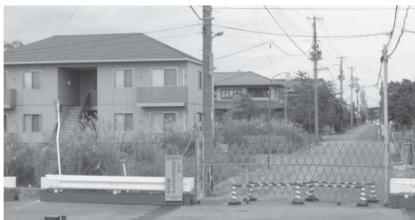
▲「復興拠点」とするため再建工事が進むJR夜ノ森駅付近。いまだに帰還困難区域と避難指示解除区域が混在している。
