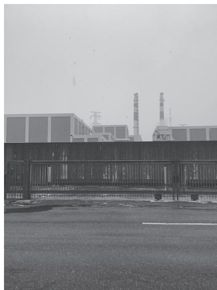
▲志賀原子力発電所。沸騰水型の原子炉で発電用タービンへ送る蒸気を直接、原子炉で作っている。左・2号機、右・1号機。
